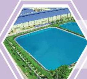
Nhà máy cấp nước sạch 12.000m 3 /ngày đêm
