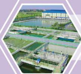
Nhà máy xử lý nước thải 8.600m 3 /ngày đêm
